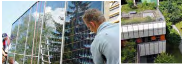
Mit der Nutzung der Sonnenkraft für die dezentrale Stromerzeugung und für hybride Heizungsanlagen befasst sich das Dachdeckerhandwerk seit rund 50 Jahren.
