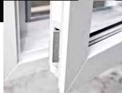
In entsprechenden Abständen an allen vier Seiten des Flügels angeordnet, drücken die verwendeten Klappen beim Verriegeln direkt gegen das Rahmeninnere.
